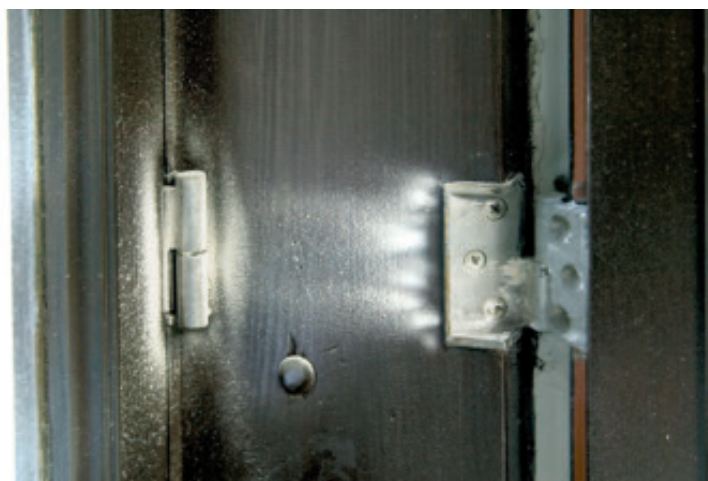
IKKUNAT ovat rakennuksen toiseksi suurin energiasyöjä. Jäätyneet kohdat saranoiden ympärillä paljastavat, mistä kohden lämpö karkaa harakoille.
